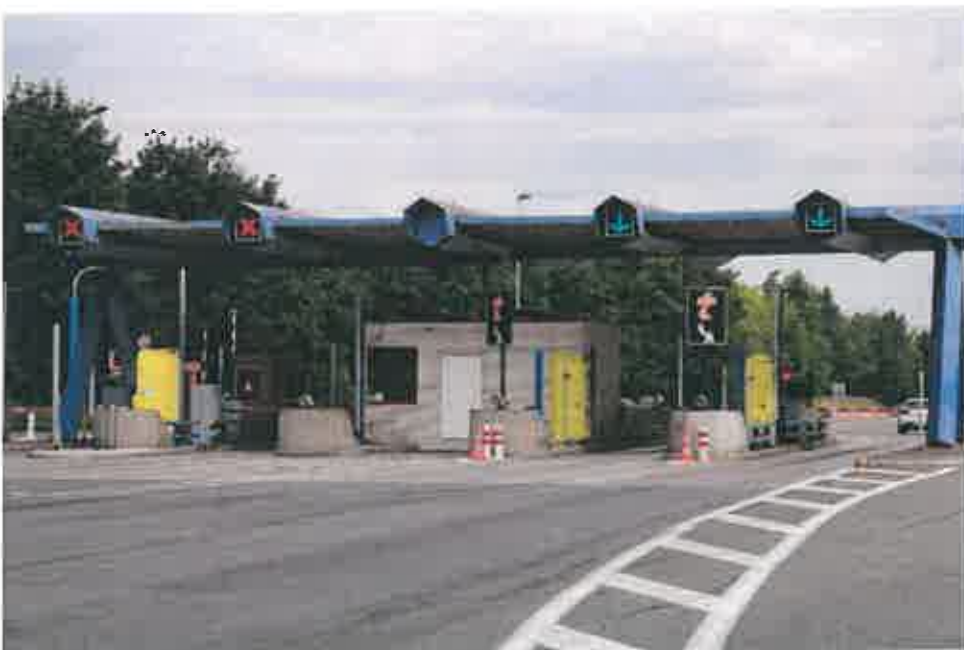
Figure 13 : Vue d'ensemble de la gare de péage de St-Quentin. © Biotope, 2018
