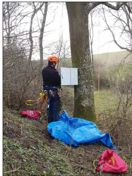
Photo 1. Installation du coffret électrique
