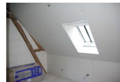
Maternité de 60 Pipistrelles communes présente dans l'isolation du rampant. Les travaux ont reconstitué un caisson à pipistrelles et remis à neuf le placo de la chambre © A.Rameaux
