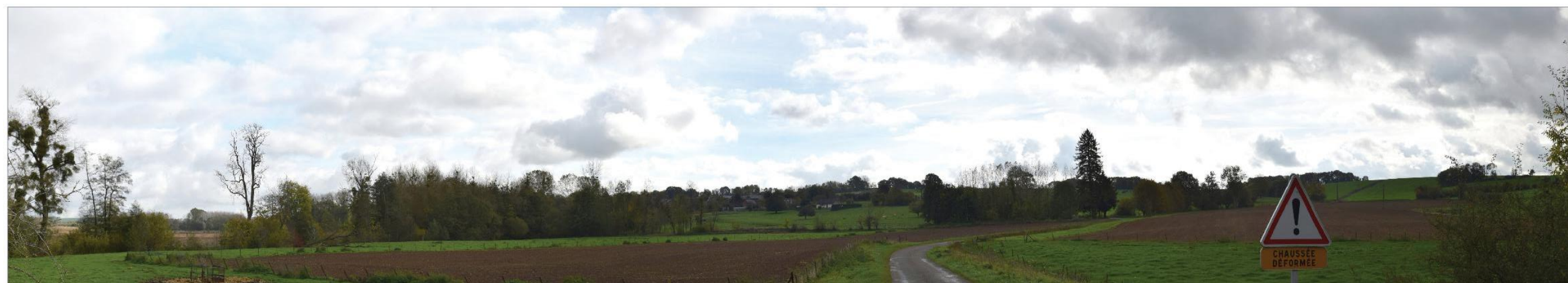
Figure 122 : PDV9 - HOURY - Sortie Sud sur le pont au-dessus de la Brune 2/2 (source : MATUTINA, 2018)
