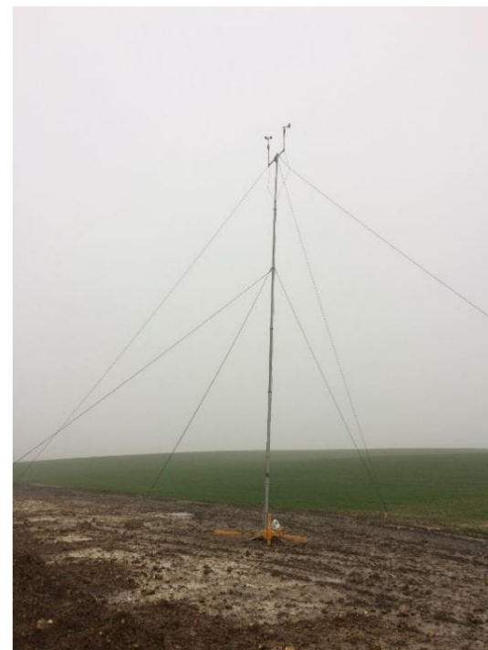
Figure 171 : Photographie du mât météorologique installé sur Tavaux-et-Pontséricourt (source : VENATHEC, 2018)
