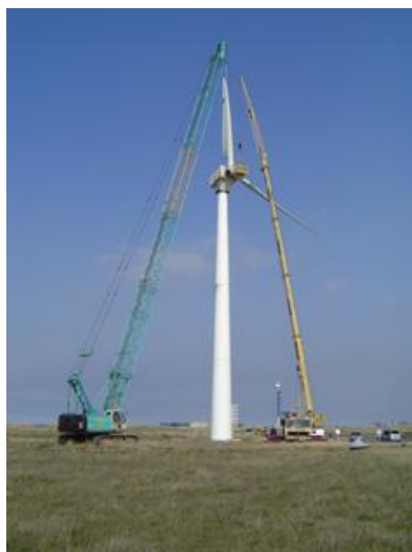
Démontage des pales – Source : Neoen
