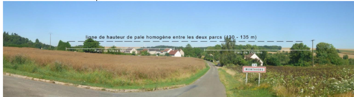
Solution retenue – La hauteur des éoliennes des deux parcs forme une ligne continue à l'horizon. Le parc de l'Osière apparaît comme une extension à l'infrastructure existante.
