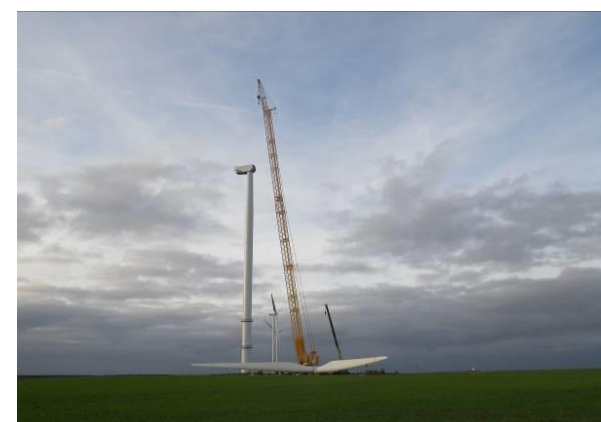
Montage d'une éolienne
