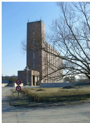
Photographie du silo existant
