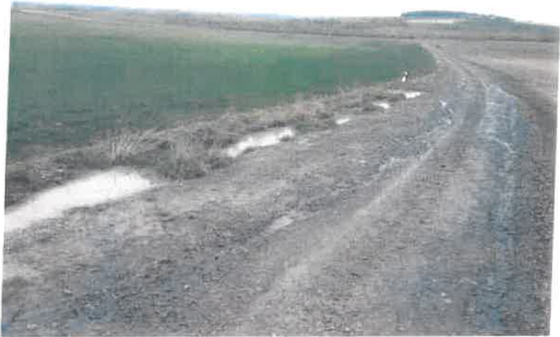
Fossé à redents
