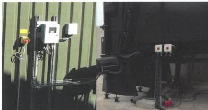
Photos : Exemples de points d'arrêts d'urgence disposés sur les containers et la trémie d'incorporation d'un site de méthanisation (CA02).
