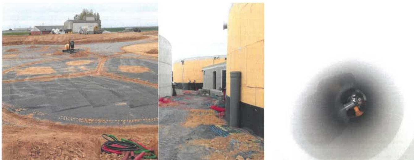
Photos : En phase de chantier, vues sur la position du drainage sous fosse avant construction en forme de Y, sur le drain autour des cuves après construction et regard de contrôle (CA02).
