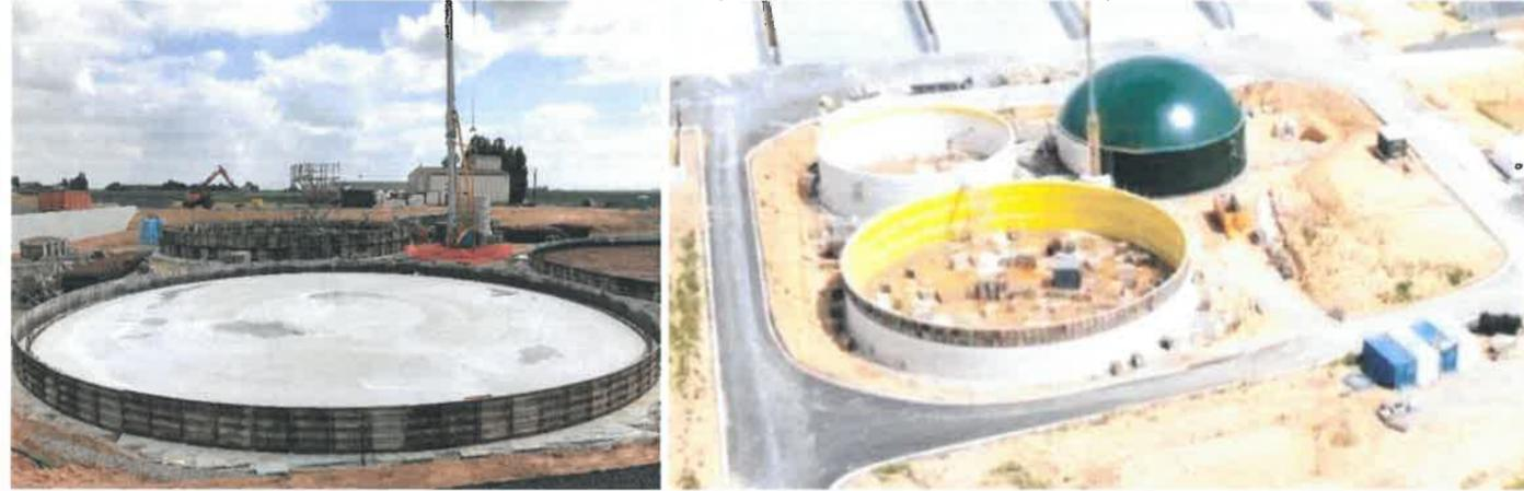
Photos : Radier béton sur un chantier de construction et vue aérienne sur la zone de rétention autour des cuves sur un site équivalent à BIOGAZ M (CA02).
