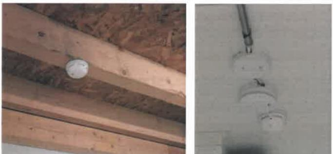
Photos : Détecteurs de fumées et de gaz dans les installations techniques d'une unité de méthanisation similaire à BIOGAZ M.
