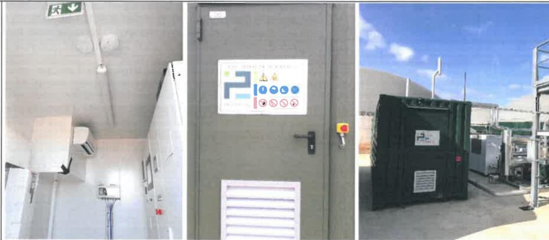
Photos : Vues sur les détecteurs de fumées et la grille de ventilation du container du module d'épuration d'un site de méthanisation (CA02).
