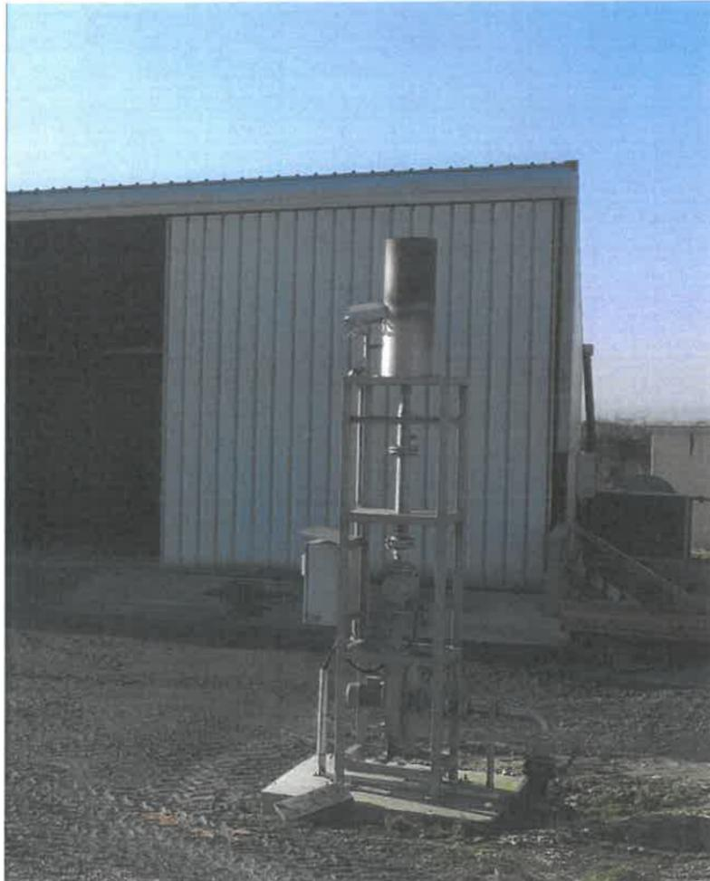
Photo : Vue sur la torchère présente sur le site du GAEC BUYSSSE (CA02) et schéma de principe.
