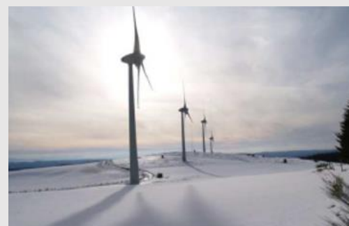
Pôle éolien des MONTS DE LACAUNE Département : Tarn (81), Aveyron (12) Puissance électrique : 74 MW 31 éoliennes, 6 parcs Mise en service : 2006 – 2008 – 2011
