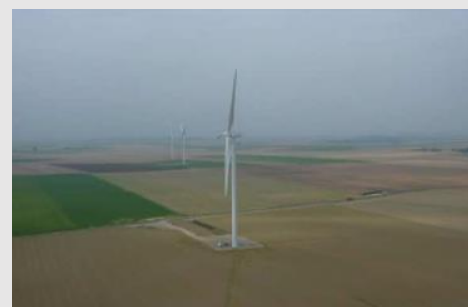
Parc éolien de CHAMPS PERDUS Département : Somme (80) Puissance électrique : 12 MW 4 éoliennes Mise en service : 2014
