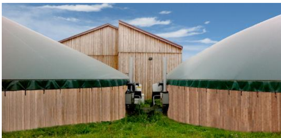
Les digesteurs du Lycée d'Obernai, photo Naskéo
