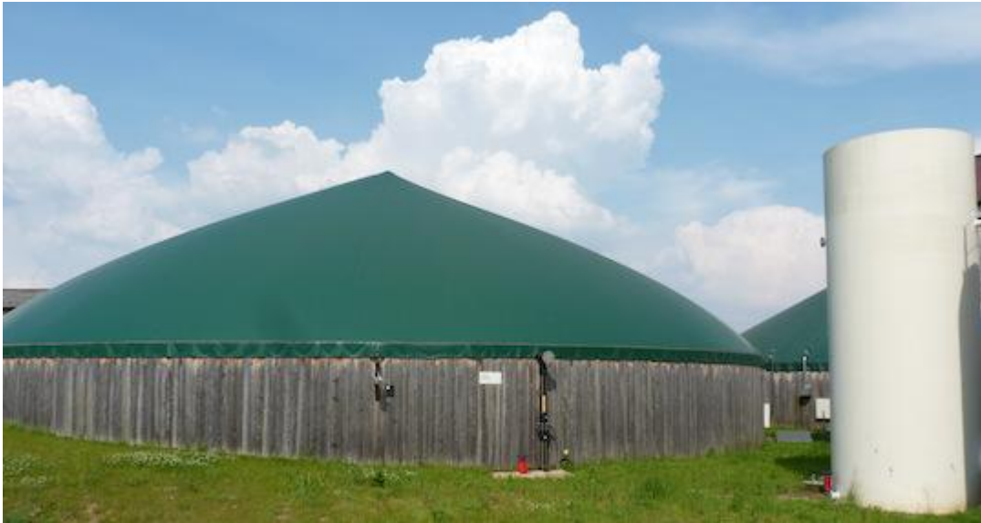
Le post-digesteur-enterrée Wolf-Systeme et cuve d'intrants liquides, photo François Bornschein
