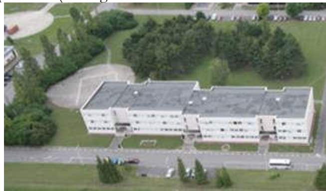
Photographie aérienne du bâtiment 233 et de l'hélistation
