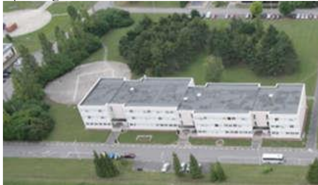
Photographie aérienne du bâtiment 233 et de l'hélistation
