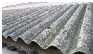
Toiture en amiante-ciment
