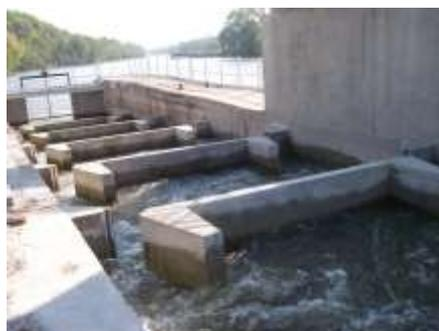
Certains ouvrages (barrages) empêchent la libre circulation des poissons (ou des sédiments). Les passes à poissons sont adaptés pour permettre le franchissement de l'obstacle.
