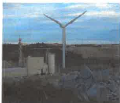
Eolienne de Centernach
