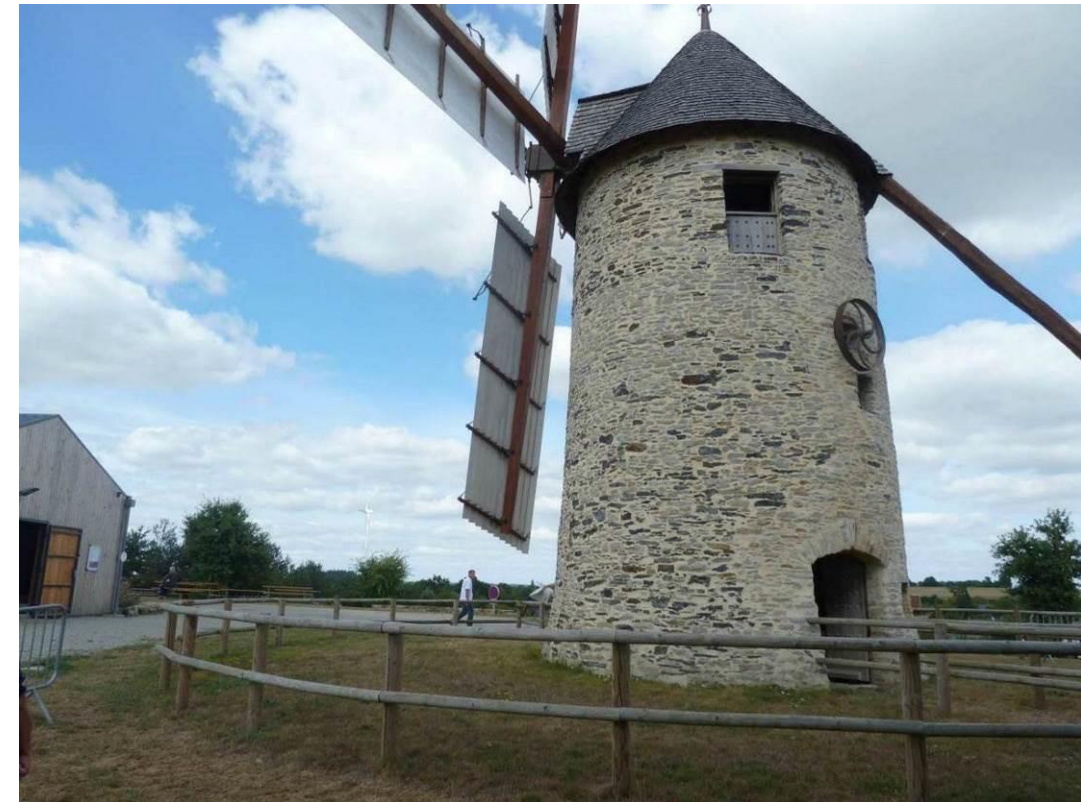
Figure 9 : Restauration d'un moulin (Loire-Atlantique) (source Boralex)
