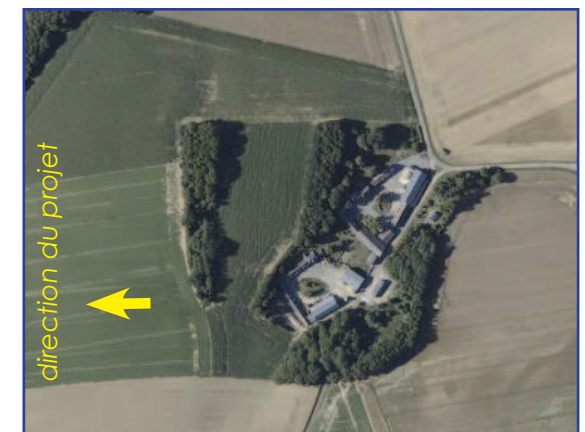
Valécourt photo-aérienne IGN. Protégé visuellement par un relief boisé.
