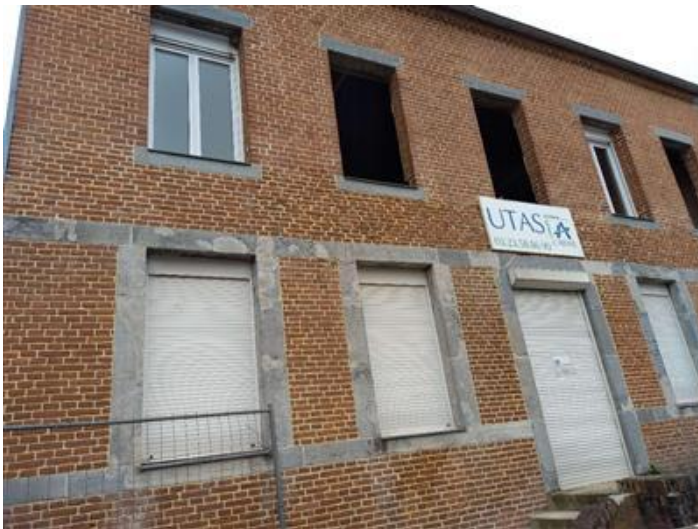
Façade de la mairie côté rue de GUISE
