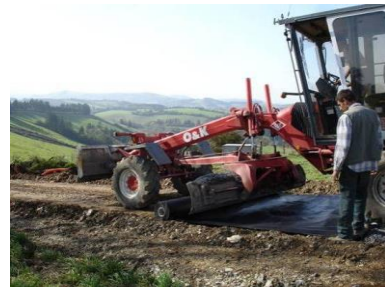
Illustration 22 : Pose du géotextile
