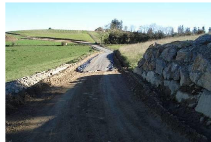
Illustration 23 : Mise en place du gravier
