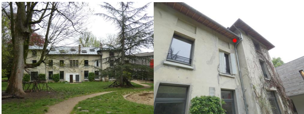
Façade ouest du bâtiment et accès au gîte de Pipistrelle commune
