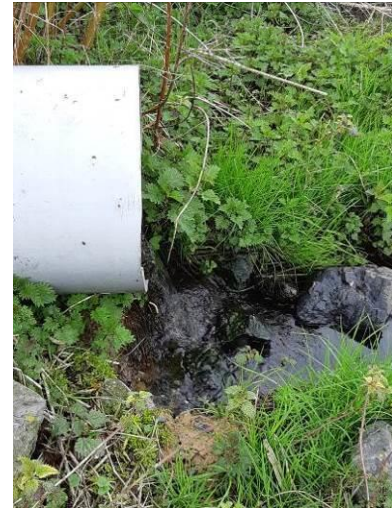
Canalisation de 400mm en entrée de bassin
