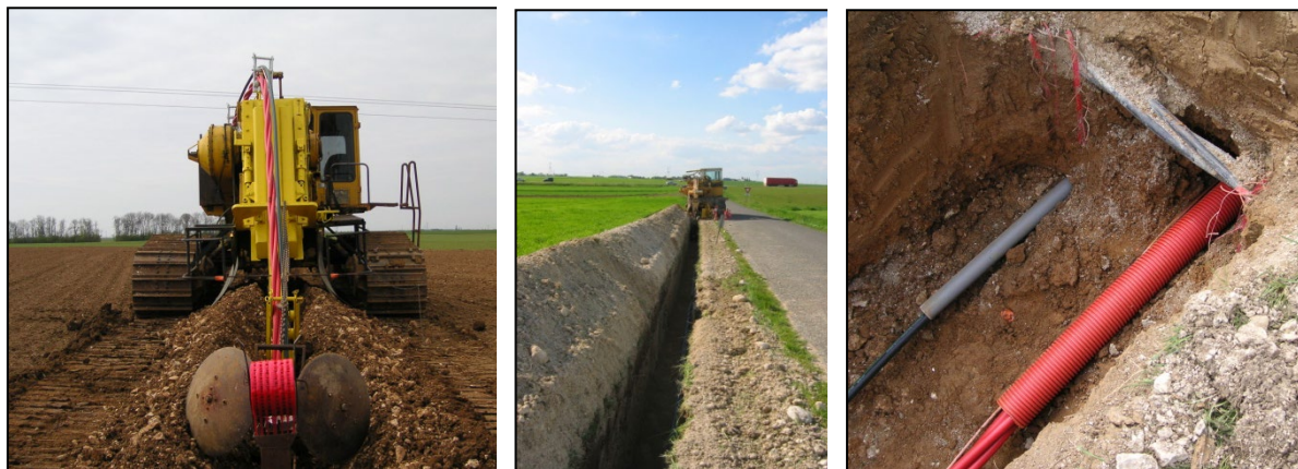
Figure 18 : Photos illustrant l'installation du câblage interne – Source : NORDEX
