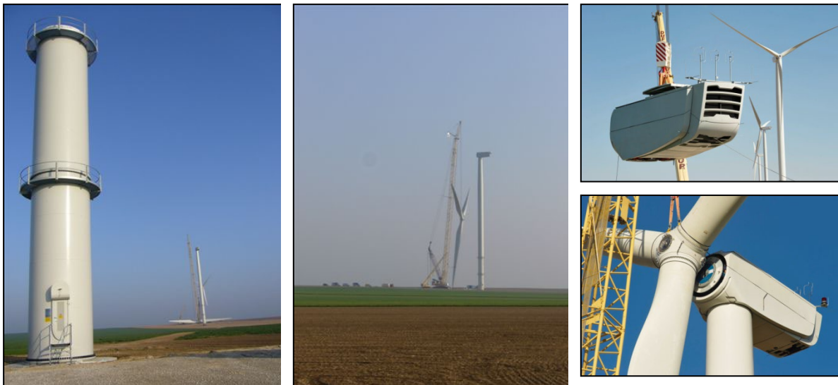
Figure 17 : Photos illustrant le montage d'une éolienne – Source : NORDEX
