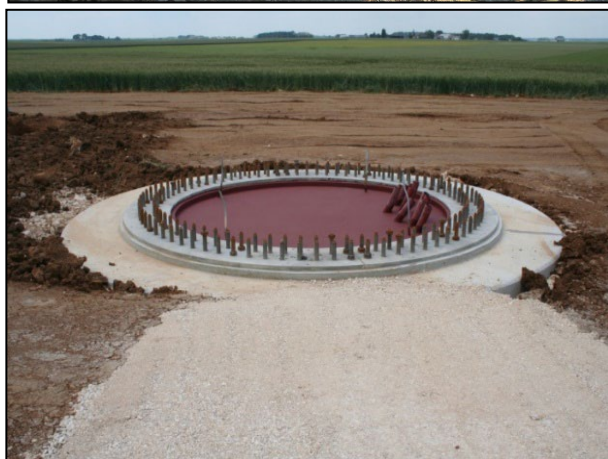
Figure 14 : Photos illustrant les étapes de la réalisation d'une fondation – Source : NORDEX
