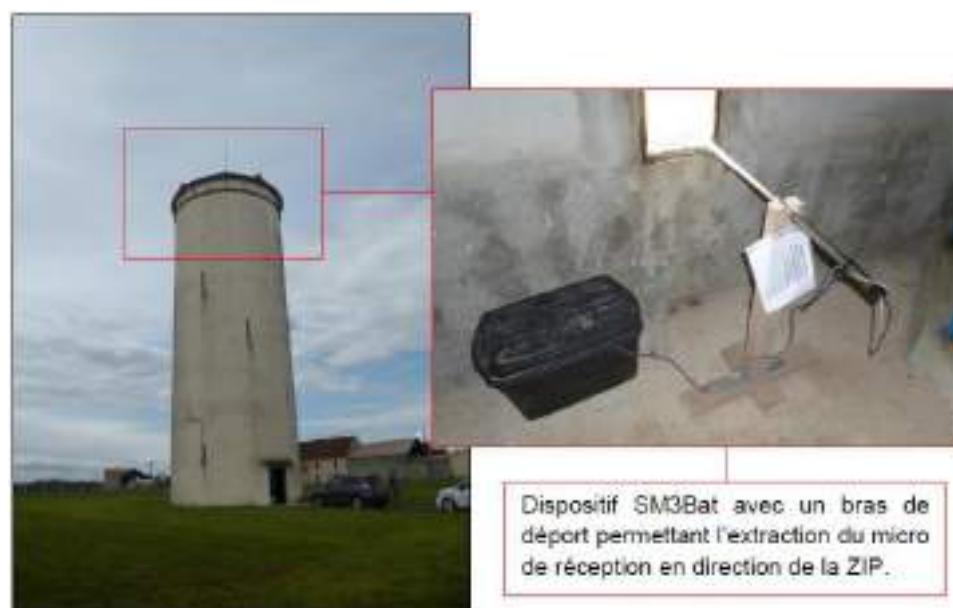
Figure 136 : Illustration photographique de l'installation du dispositif SM3Bat au niveau du château d'eau de La Chapelle sur Chézy (Envol Environnement, 2019)
