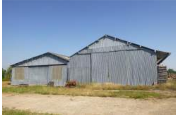
Figure 92 : Hangar en tôles offrant très peu de potentialités de gîtage (point 27)(Envol Environnement, 2019)
