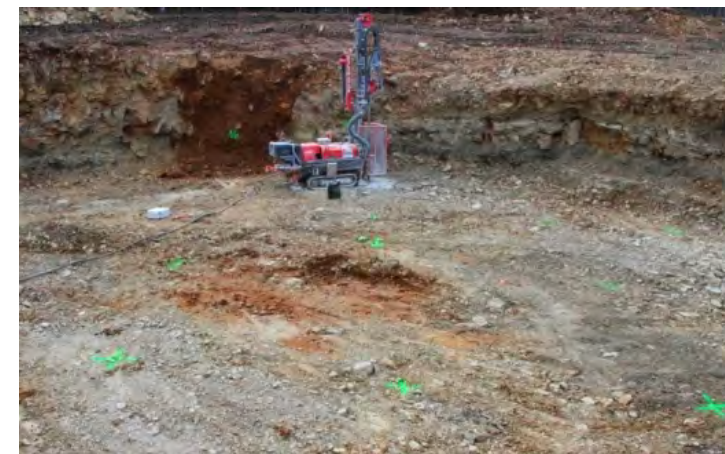
Illustration 75 : Foreuse géotechnique sur un chantier éolien (Source : Abies)
