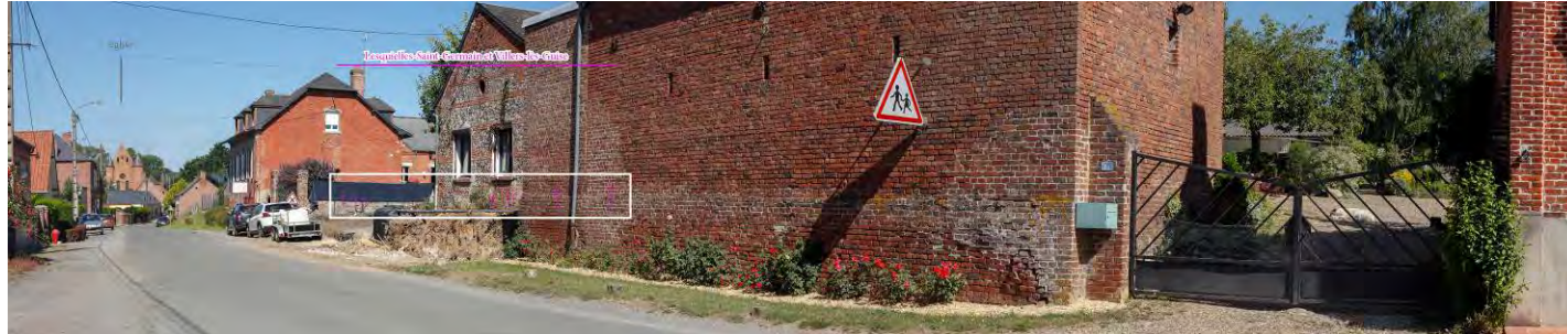
Illustration 73 : Vue sur l'église Sainte-Aldegonde depuis la rue du Général de Gaulle à Malzy
