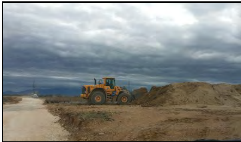
Figure 63 : Reprise de la terre stockée pour le remblayage des fondations (Source : Abies, suivi de chantier éolien)
