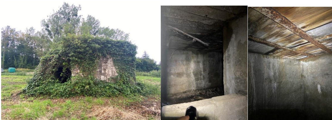
Photographie 6: Photographies du Blockhaus de Surfontaine
