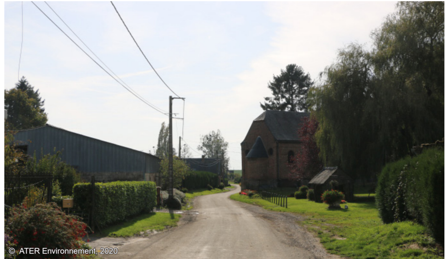
Fig. 56 : D773, rue principale de Colonfay avant enfouissement.
