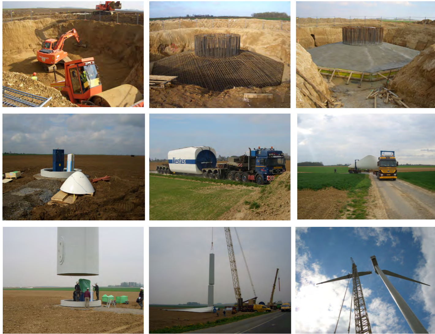
Photographie 2 : Aperçu des différentes phases de travaux
