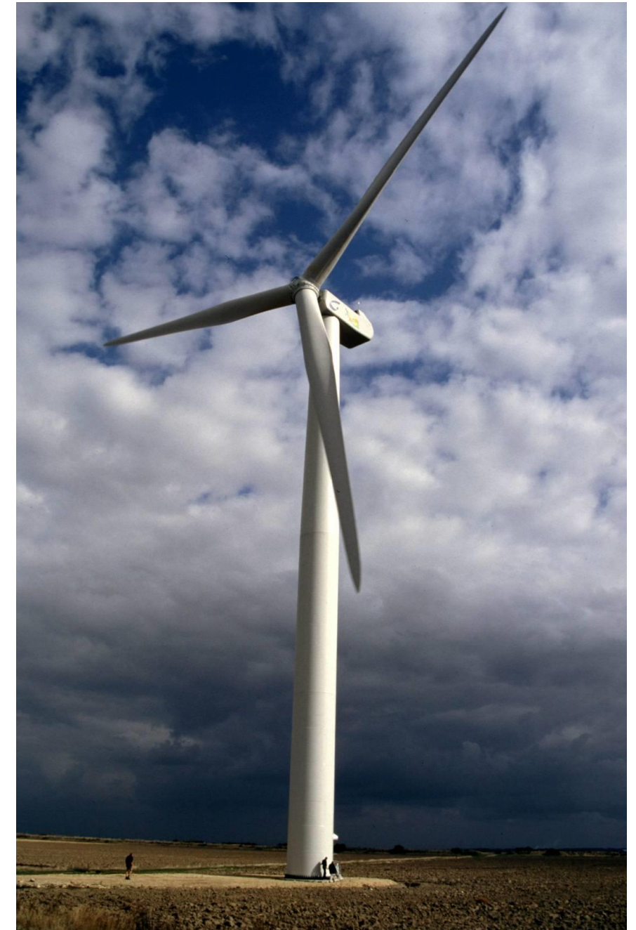
Photo 1 : Eolienne du parc éolien de Bouin (Vendée)
