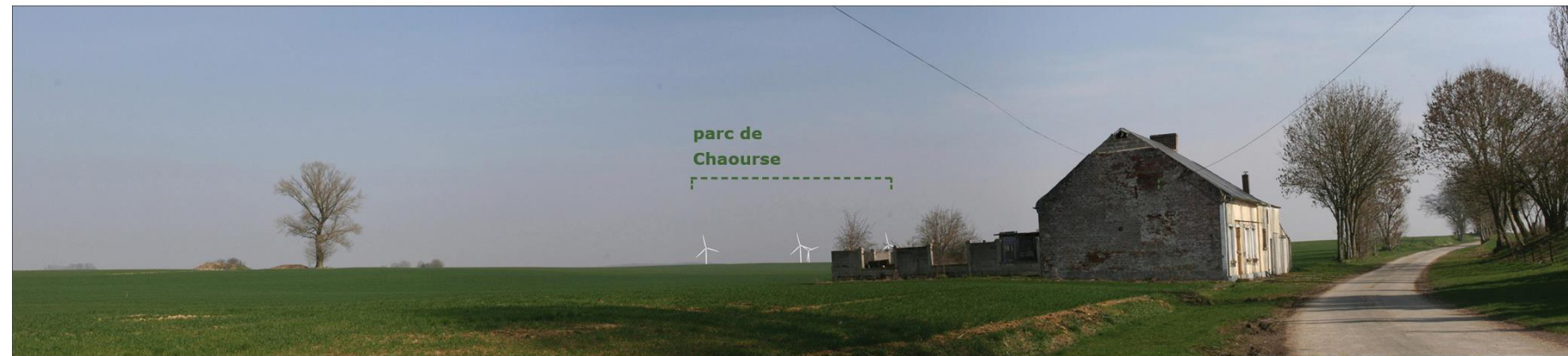
Ph.11 État initial avant montage
