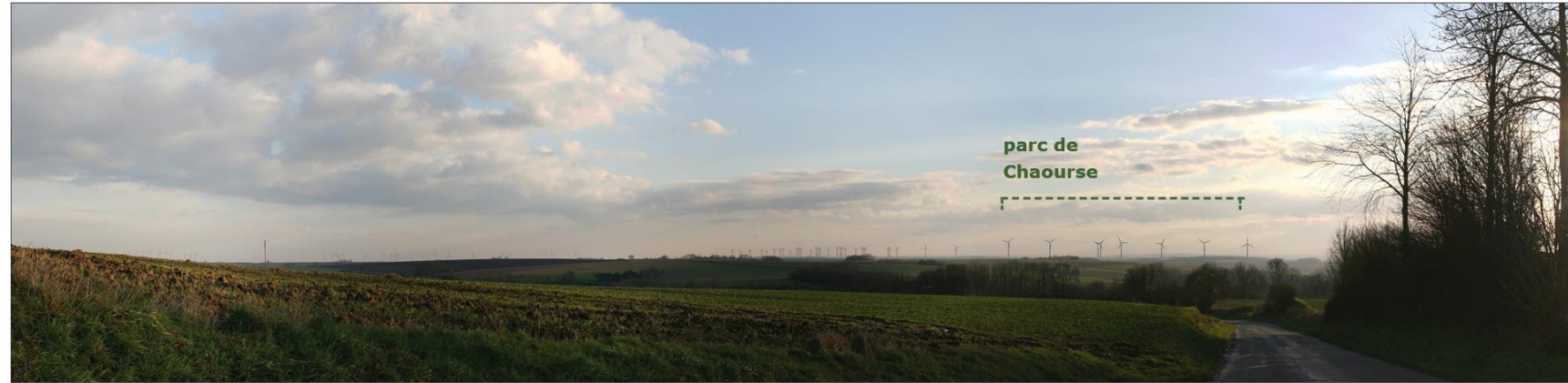
Ph.24 État initial avant montage
