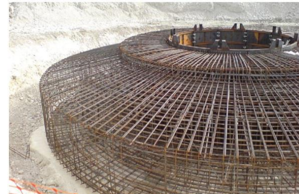
Photo 5 : Excavation et préparation de l'armature
