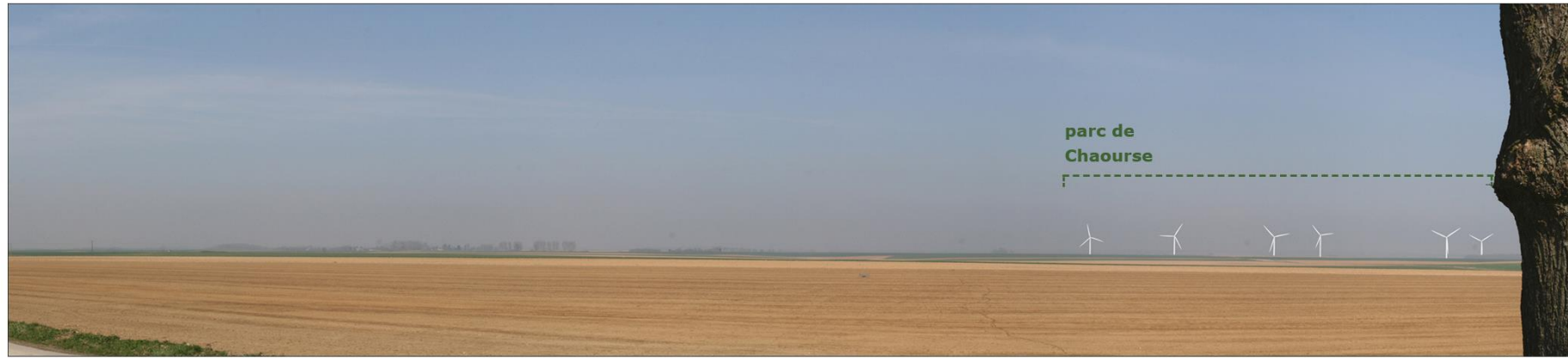
Ph. 08 État initial avant montage
