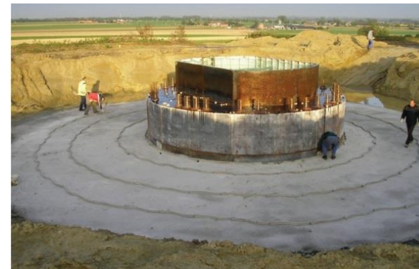
Photo 6 : Durcissement béton
