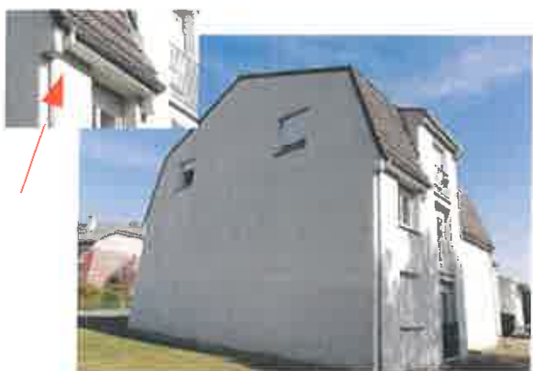
Bâtiment E, avant travaux ITE, septembre 2018 © S.Declercq
