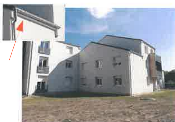
Bâtiment A, après travaux ITE, septembre 2018 © S.Declercq
