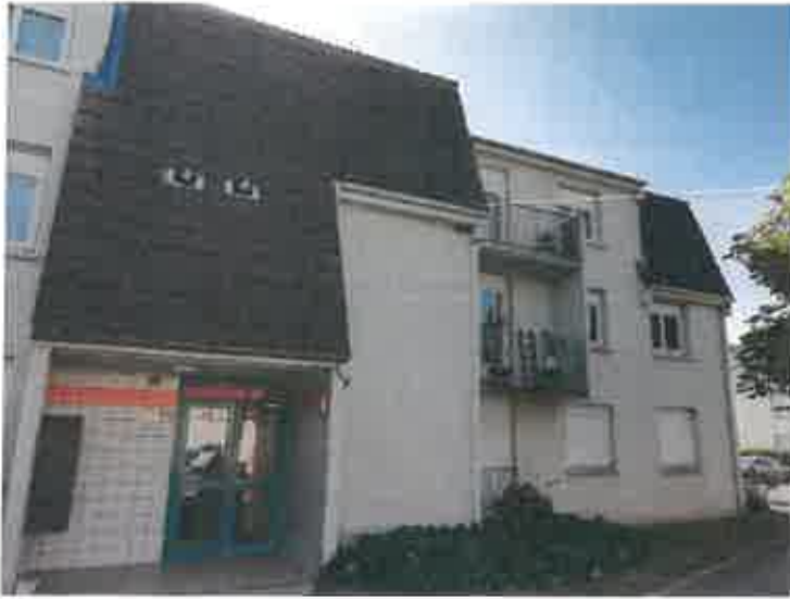
Bâtiment D, vue d'ensemble côté rue © S.Declercq
