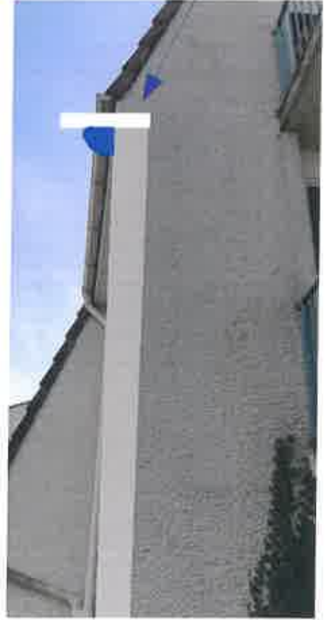
État initial : visualisation de l'ITE (gris), le débord de couverture (blanc) et le nid artificiel (bleu)
