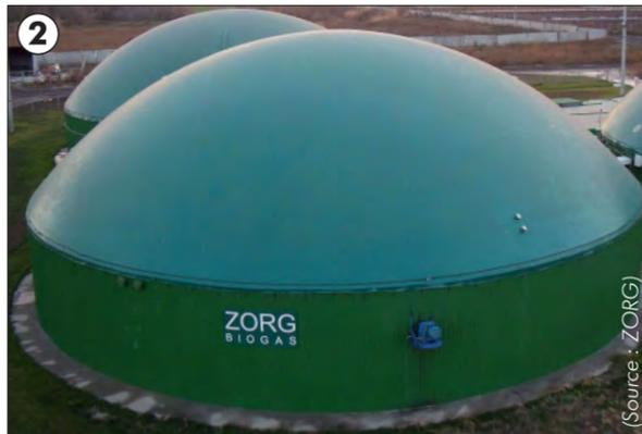
Exemple d'un digesteur et d'un gazomètre
