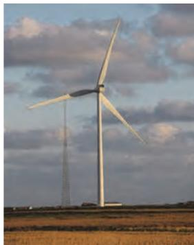
Le modèle d'éolienne sélectionné pour ce projet est une VESTAS V117 (3,3MW), avec une hauteur de mât de 106 mètres et un diamètre de rotor de 117 mètres, soit une hauteur totale de 164,5 mètres.
