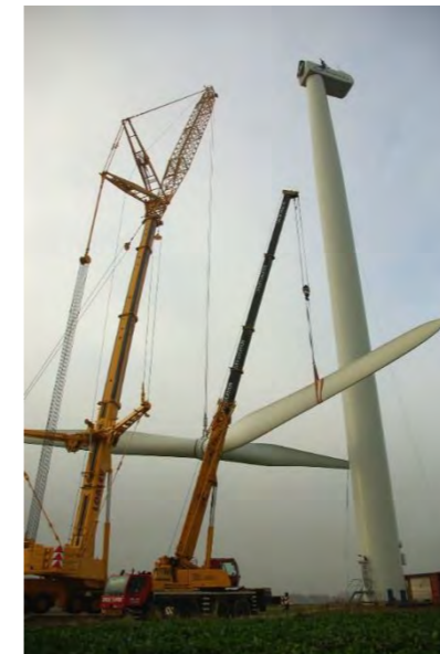
Figure 28 d'exemple de séquences d'assemblage d'une éolienne
