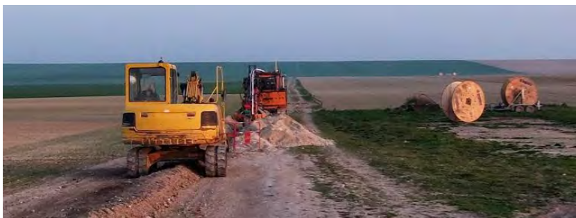
Figure 27 d'un exemple de travaux pour l'installation du raccordement enterré
