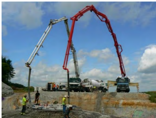
Figure 26 de ferrailage et coulage des fondations
