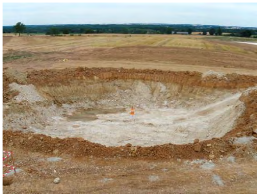
Figure 25 exemple de fondation excavée et remblais
