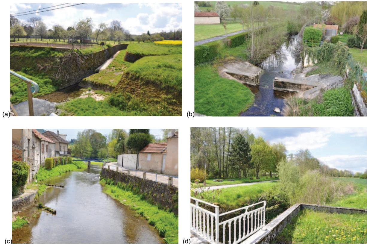
Figure 3-13 : Les principaux types d'aménagements modifiant les conditions d'écoulement et possiblement facteurs d'exhaussement de la ligne d'eau de crue : busage et canalisation (a), seuils et ouvrages en lit mineur (b), corsetage en milieu urbain (c) et ouvrages liés à un ancien moulin (d)
