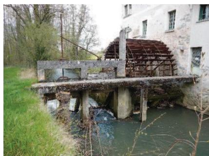
L'ancien moulin, en photo ci-dessus, a été modélisé par 4 dalots (2 inférieurs dans l'écoulement et deux supérieurs dans le muret) pour mieux représenter les écoulements possibles.
