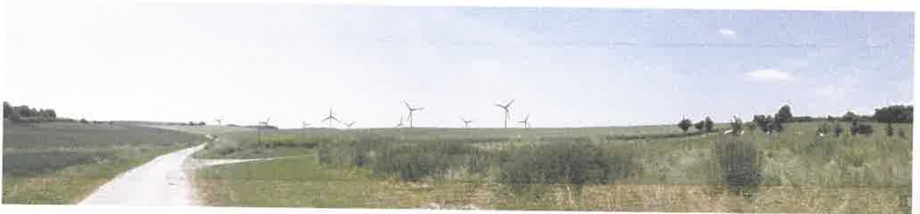
Photographie du parc construit
