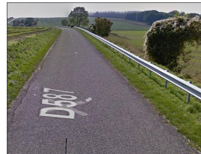
Photo 1. Accotement routier avec haie discontinue d'arbustes concerné par l'éolienne E1 (source : street view - google maps)
