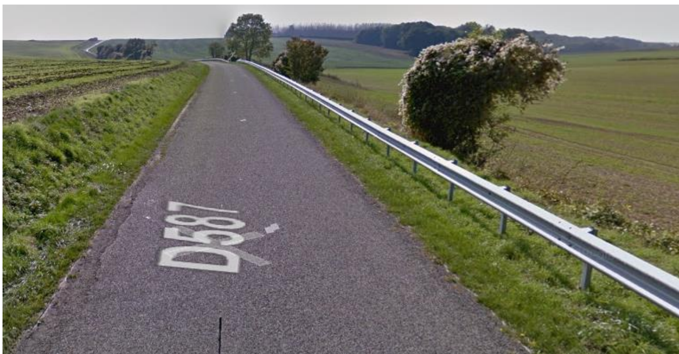
Photo 1. Accotement routier avec haie discontinue d'arbustes concerné par l'éolienne E1 (source : street view - google maps)
