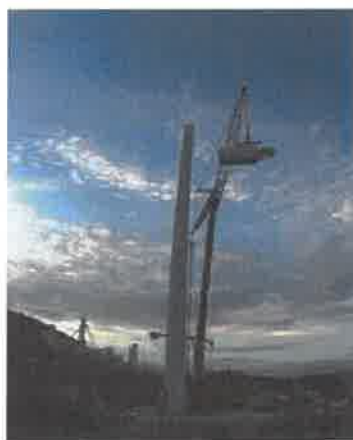
Démantèlement de l'éolienne
