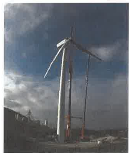
Démantèlement de l'éolienne
