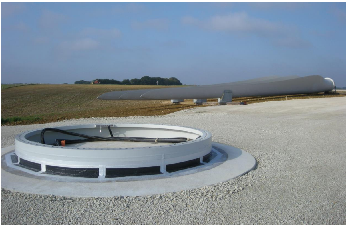
Montage d'une section de mât
