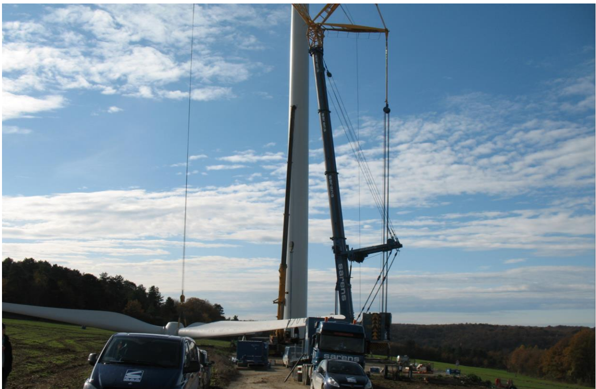
Préparation au levage du rotor assemblé au sol
