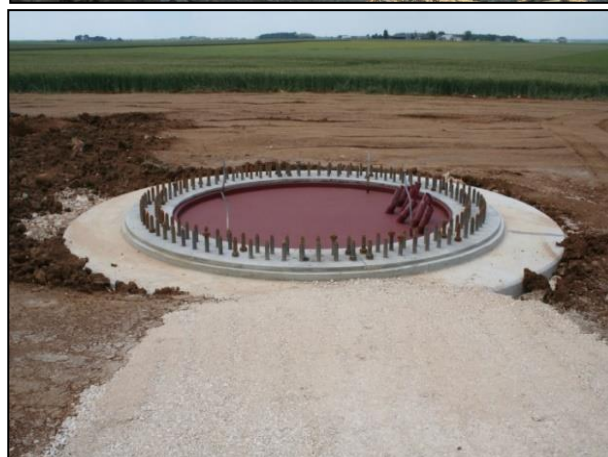
Figure 13 : Photos illustrant les étapes de la réalisation d'une fondation – Source : NORDEX
