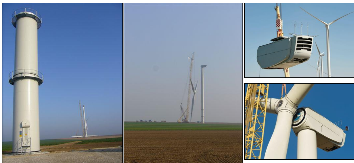
Figure 16 : Photos illustrant le montage d'une éolienne – Source : NORDEX
