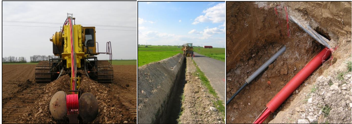
Figure 17 : Photos illustrant l'installation du câblage interne – Source : NORDEX
