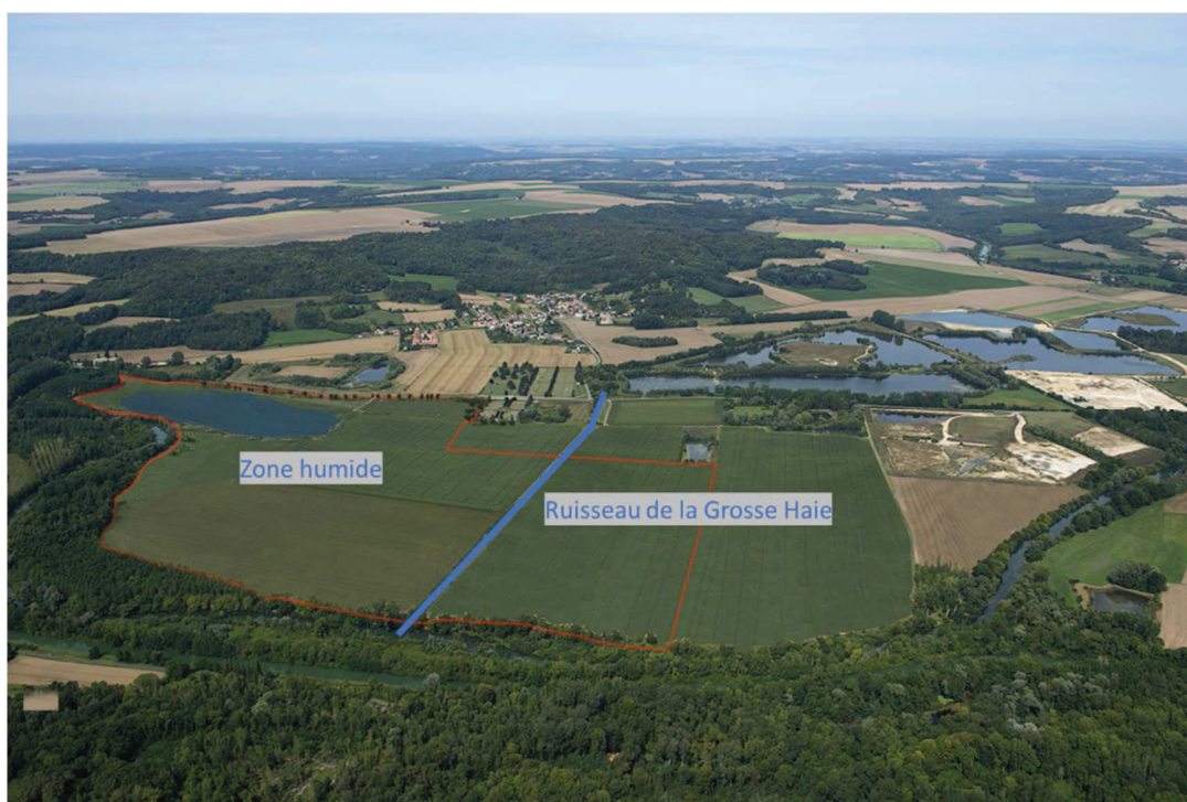
Figure 16 : Site après remise en état et mise en valeur des zones humides, vue depuis le Sud-Est (photomontage réalisé par ARCHI-SERVICES)
