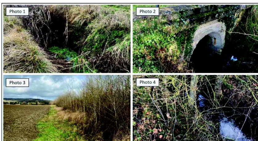
Figure 8 : Photographies du cours d'eau prises lors du déplacement terrain [INGEROP]
