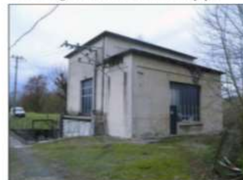
Vue 6 : Bâtiment aval, centrale en fonctionnement (parcelle 69)
