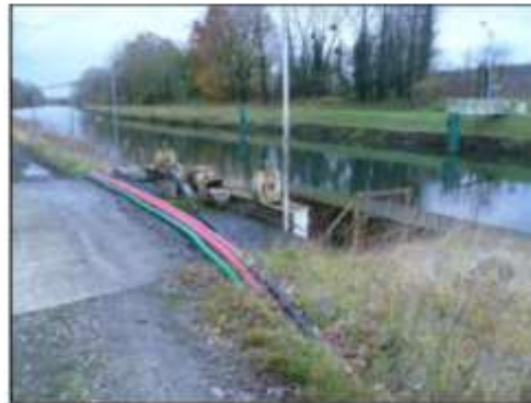
Vue 12 : Passage au niveau de la centrale à rééquiper
