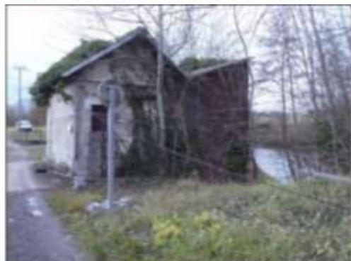
Vue 5 : Bâtiment amont, centrale à rééquiper (parcelle 68)
