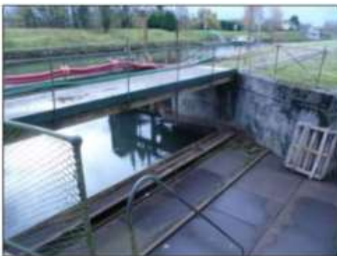
Vue 11 : Passerelle au niveau de la centrale existante
