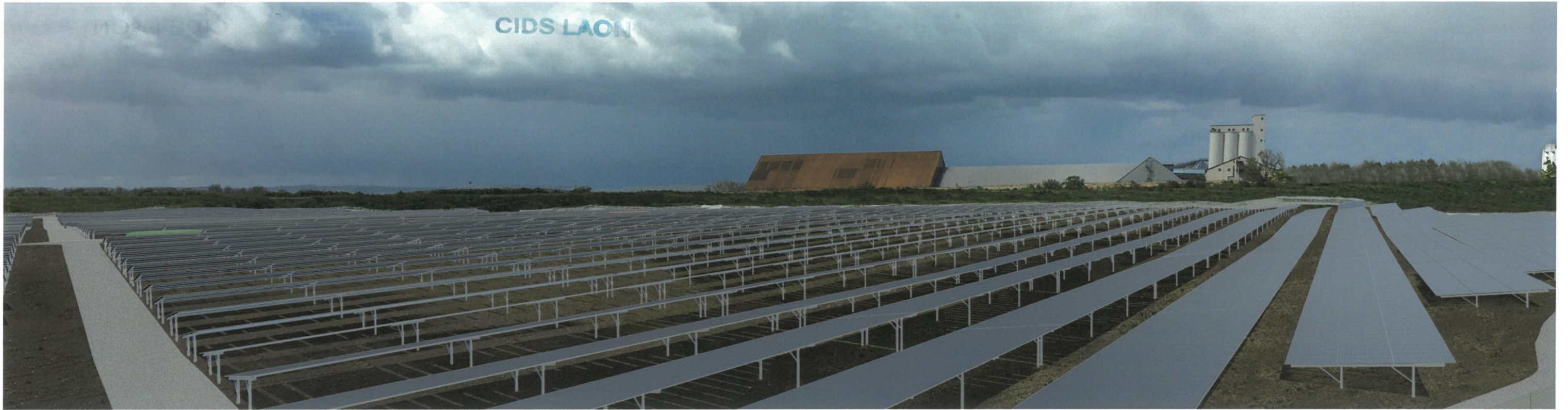
Point de vue n°3 - Vue depuis le merlon au nord du site - sans mesures paysagères
