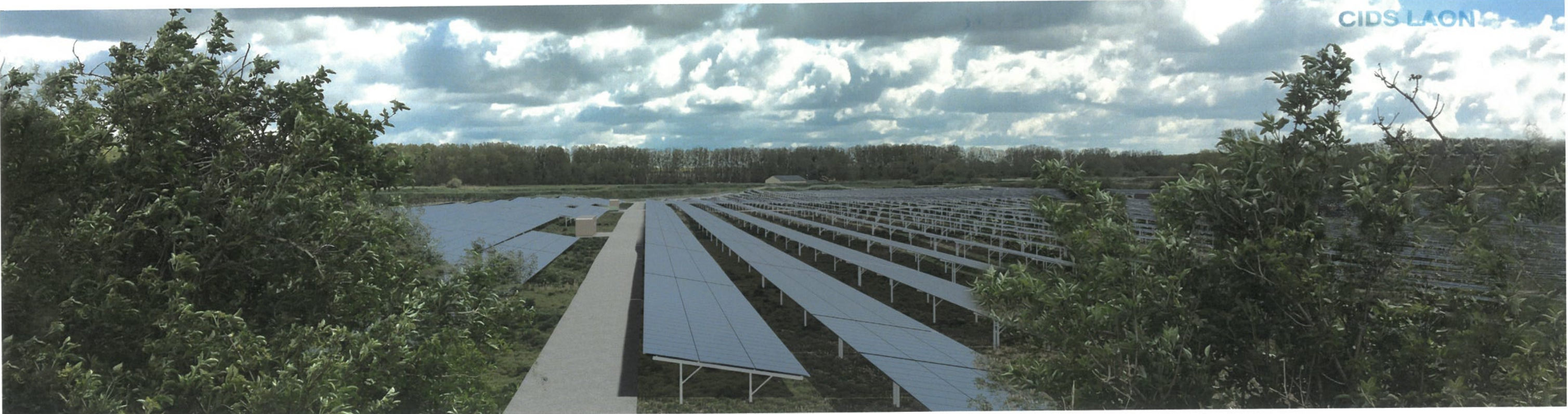
Point de vue n°4 - Vue depuis le merlon à l'ouest du site - sans mesures paysagères
