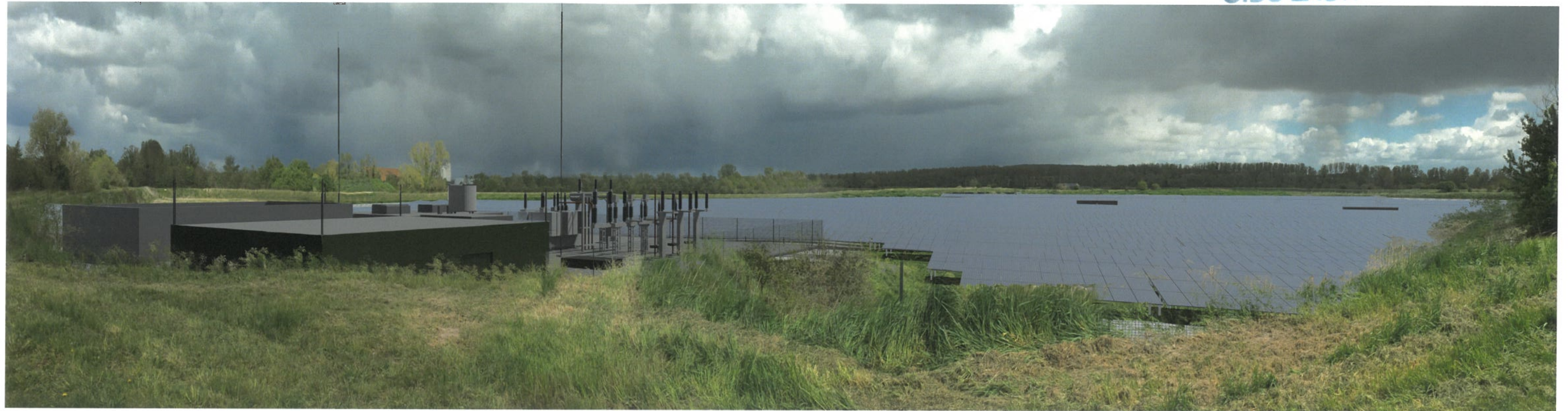
Point de vue n°1 - Vue depuis l'entrée du site au sud - sans mesures paysagères
