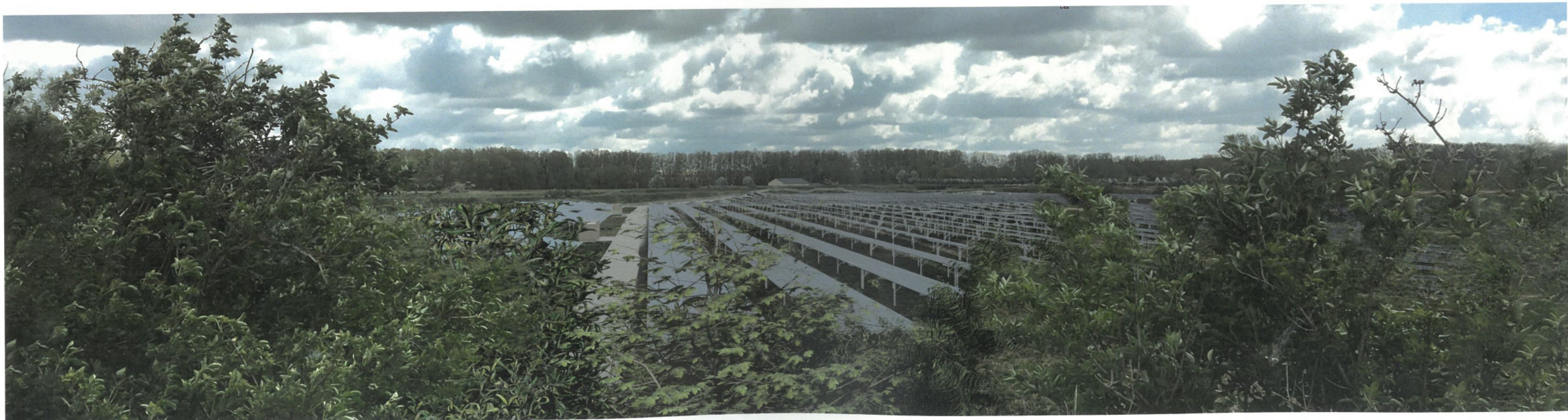
Point de vue n°4 - Vue depuis le merlon à l'ouest du site - avec mesures paysagères
