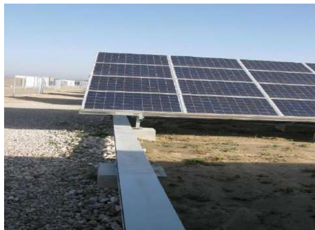
Figure 27 : Exemple d'un chemin de câbles
