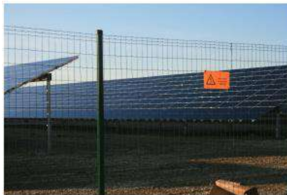
Figure 34 : Clôture grillagée autour d'une centrale solaire photovoltaïque
