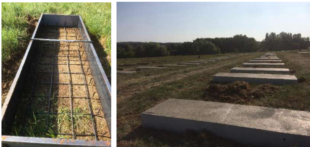
Figure 20 : Photographie de mise en place de longrine – source : ENGIE Green
