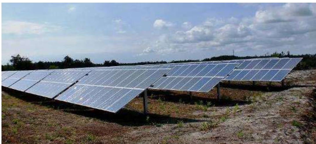
Figure 16 : Exemple de centrale photovoltaïque équipée de panneaux fixes – technologie cristalline (couche épaisse)
