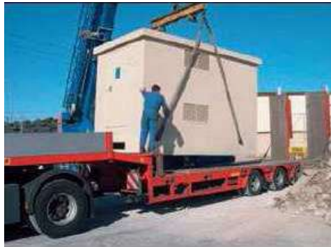
Figure 33 : Déchargement d'un poste électrique
