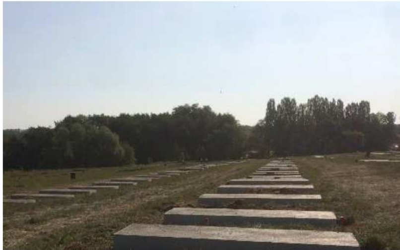
Figure 14. Exemple de longrines posées au sol lors de la construction d'une centrale photovoltaïque
