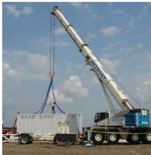
Figure 32 : Engin utilisé pour la pose des postes onduleurs
