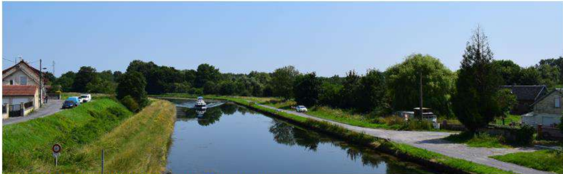
La canal de Saint Quentin accompagné des marais de la Somme en arrière-plan (Point photo 38)
