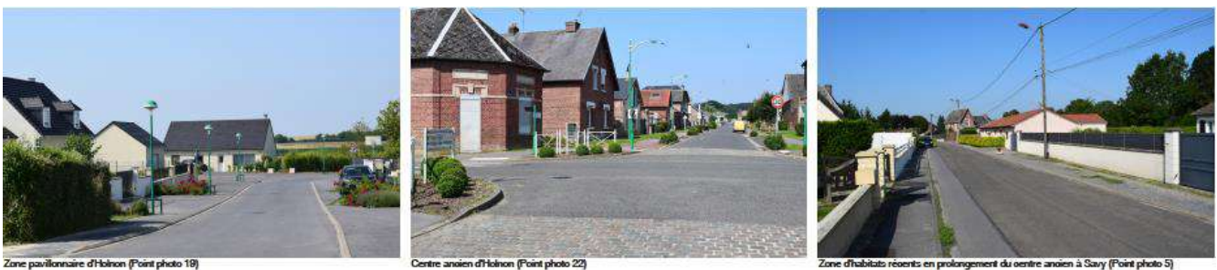
Figure 91 : Composantes urbaines : les formes bâties et architecturales – source : Savart Paysage
