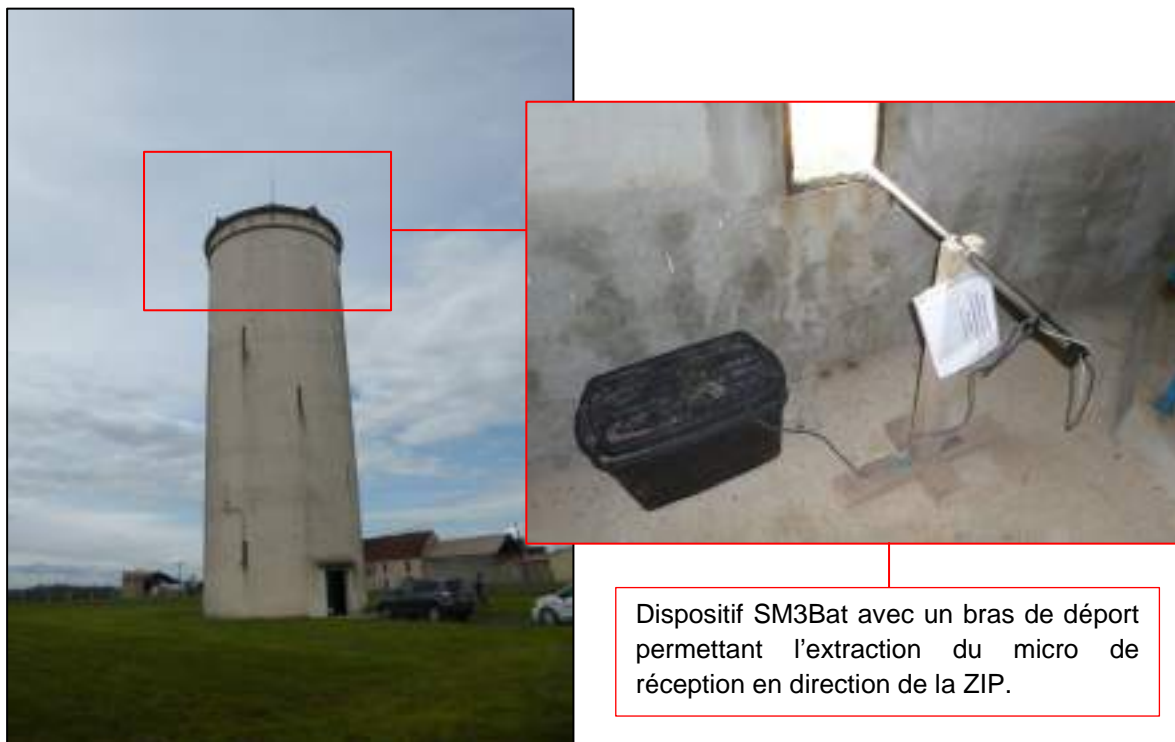
Figure 76 : Illustration photographique de l'installation du dispositif SM3Bat au niveau du château d'eau de La Chapelle sur Chézy
