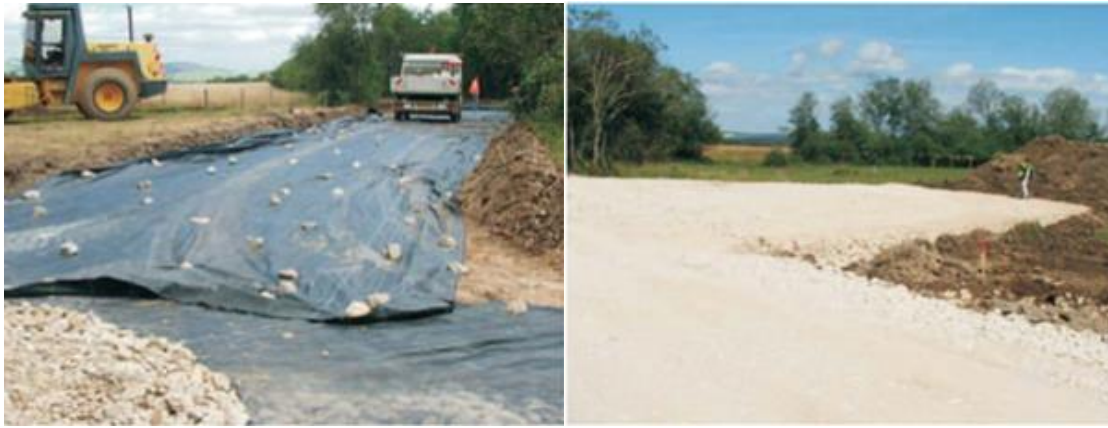
Figure 13 : Exemple de pose d'un géotextile de protection des sols (à gauche), état final d'une plate-forme (à droite)
