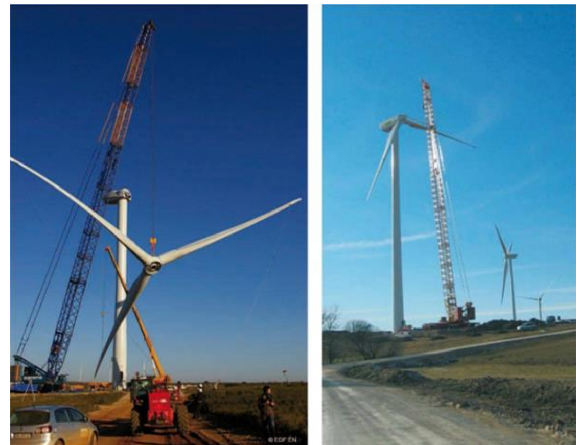
Figure 15 : Exemple de montage du rotor (à gauche) , montage pale par pale (à droite)
