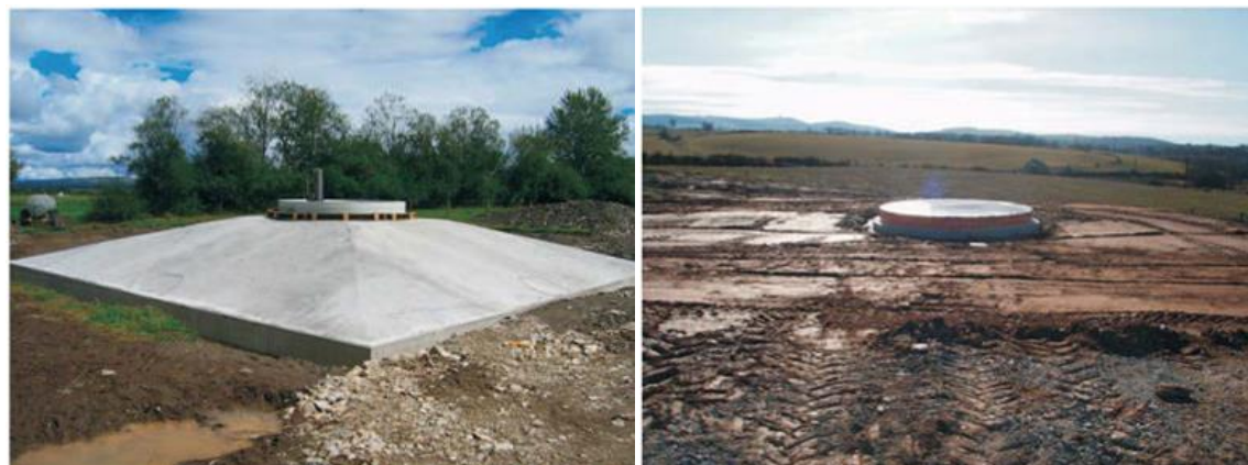
Figure 14 : Exemple de massif béton terminé (à gauche), état final après remblaiement (à droite)
