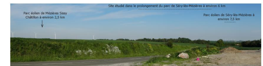
Figure 5 : Vue vers l'est depuis la sortie sud-est d'Itancourt sur la RD57. Exemple depuis le nord-ouest
